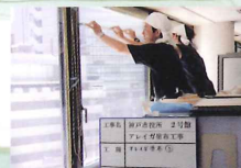
神戸市役所2号館塗布工事
